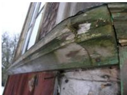
Kiideva mõisa peahoone vahefriis, mis täidab ühtlasi ka veelaua ülesannet. (Foto: M. Loit)
