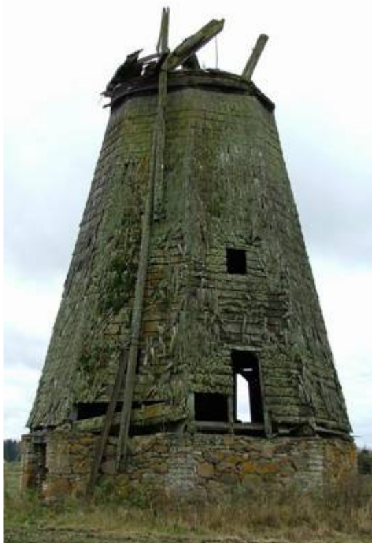
Sindlikattega Mardi tuuleveski Pärnumaal. Sindel on naelutatud tihedale rõhtlaudisele. (Fotod: J. Vali)
