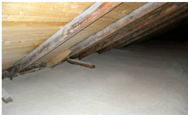
Puitkiudvill sobib hästi ka lagede soojustamiseks. (Foto: M. Loit)
