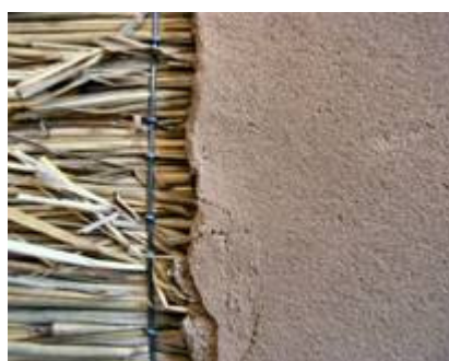
Savikrohviga kaetud pillirooplaat.
