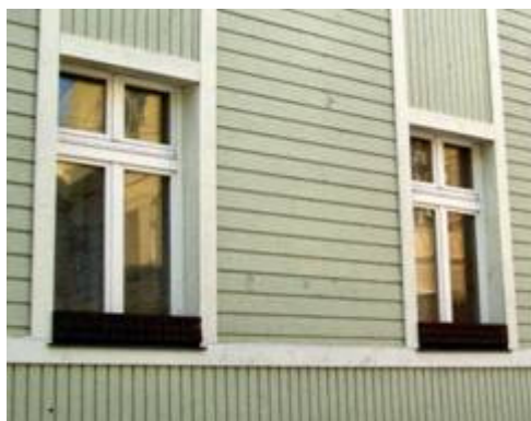
„Laskeavadena“ mõjuvad aknad liiga paksus soojustuskihis. (Foto: M. Loit)
