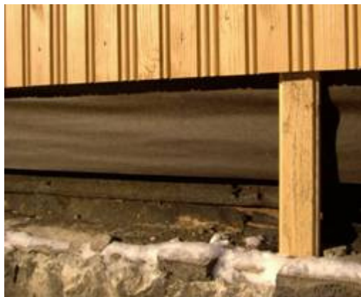
Uue laudise taha paigaldatud tuuletõkkepaber. (Foto: M. Loit)
