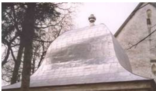
Väike-Maarja kirikuaia barokk-kabeli tinatatud raudplekist katus 1998. a. (Foto: Ü. Puustak)
