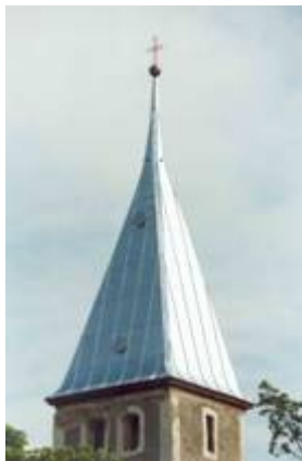
Karuse kiriku tsingitud terasplekist tornikiiver 1998. a. (Foto: Ü. Puustak)
