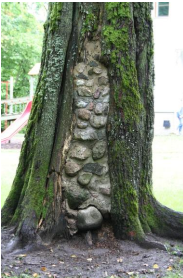
Plombeeritud puu Sürgavere pargis – puule tekitatakse kasu asemel kahju. Foto: Sulev Nurme
