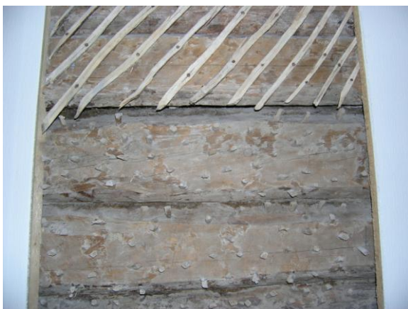
Varem krohviti lubimördiga otse palkseintele, mis olid paremaks nakkumiseks puupulki täis löödud. Krohvi hoidmiseks on seinale kinnitatud ka diagonaalselt ja risti naelutatud krohvipeerge ja rooplaate. Foto: Kaire Tooming
