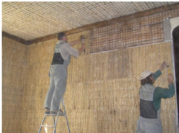
Pilliroost krohvimati ehk rooplaadi paigaldamine. Foto: Säätva Renoveerimise Infokeskus
