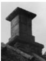
Jaagu talu korstnapiip, EVM
