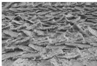
Kahjustunud laastukatus (Fotod: M. Loit)
