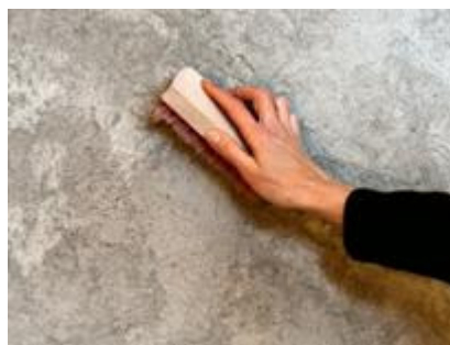
Krohvipinna puhastamine lahtistest osakestest. (Foto: K. Zova)
